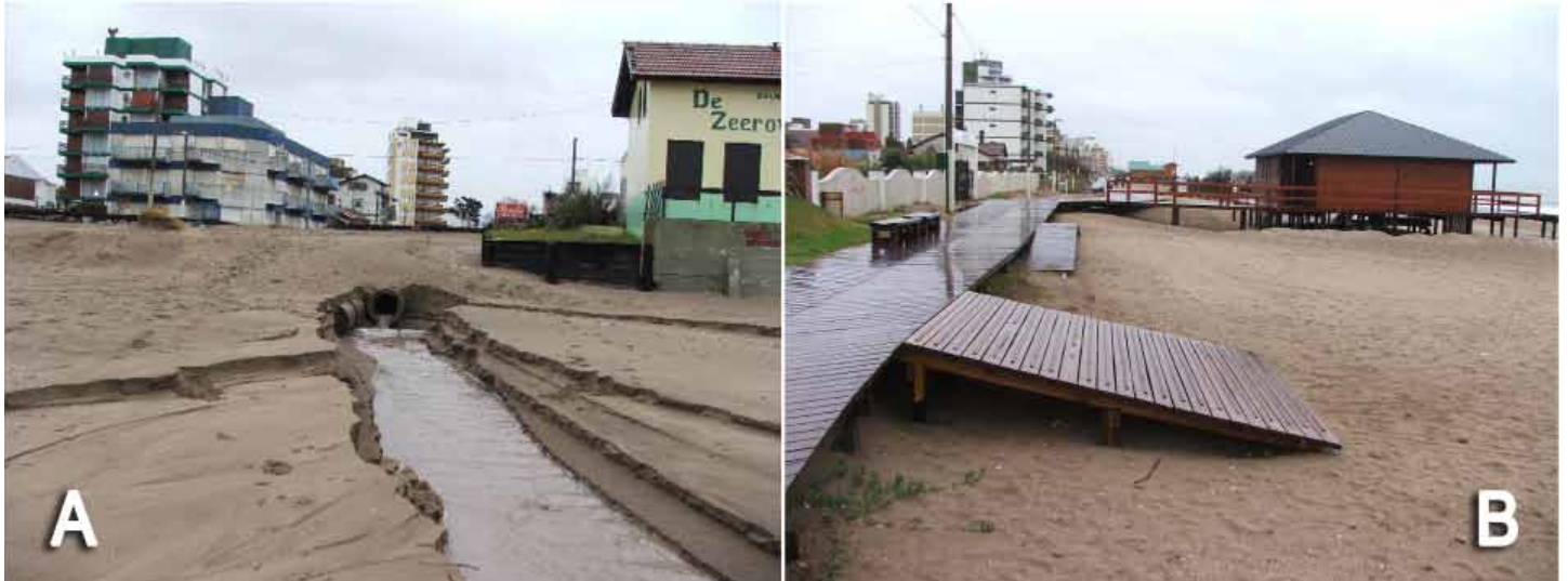
A) Inadecuada planificación de desagües sobre la playa. B) Algunas medidas de restauración de la duna frontal: pasarelas elevadas y edificaciones sobre pilotes.
