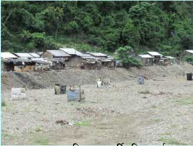
नदिमा चर्पी निर्माण
