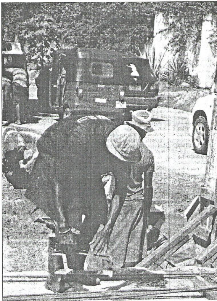
Mafundi ujenzi wa Kampuni ya Estim wakijonga mtaro wa barabara ya Morocco-Mwenge Dar es Salaam jana, inayopanuliwa kwa fedha sh. bilioni nne ambazo zilikuwa zitumike kwa ajili ya sherehe ya Uhuru iliyofutwa na Rais Dk. John Magufuli mwaka jana. (PICHA NA DOTTO MWAIBALE)
